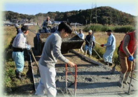
自主施工による農道舗装
